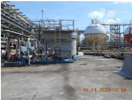
ภาพที่ 2.2-3 ระบบบำบัดน้ำเสียเบื้องต้น CPI
