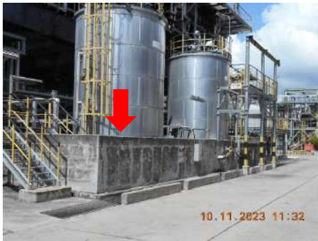
ภาพที่ 2.2-30 Band Wall ป้องกัน Tank pit
