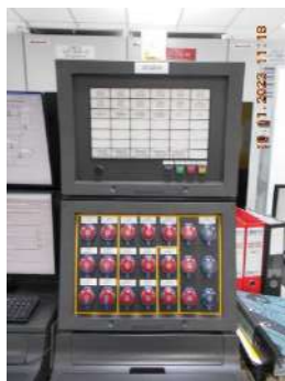
ภาพที่ 2.2-28 ระบบ Interlock System ควบคุมการจ่ายสารเข้าสู่ระบบ
