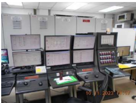
ภาพที่ 2.2-26 ระบบ Distributed Control System (DCS)
