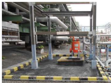
ภาพที่ 2.2-19 Slop Oil Tank รวบรวมเศษน้ำมันจากหน่วย CPI
